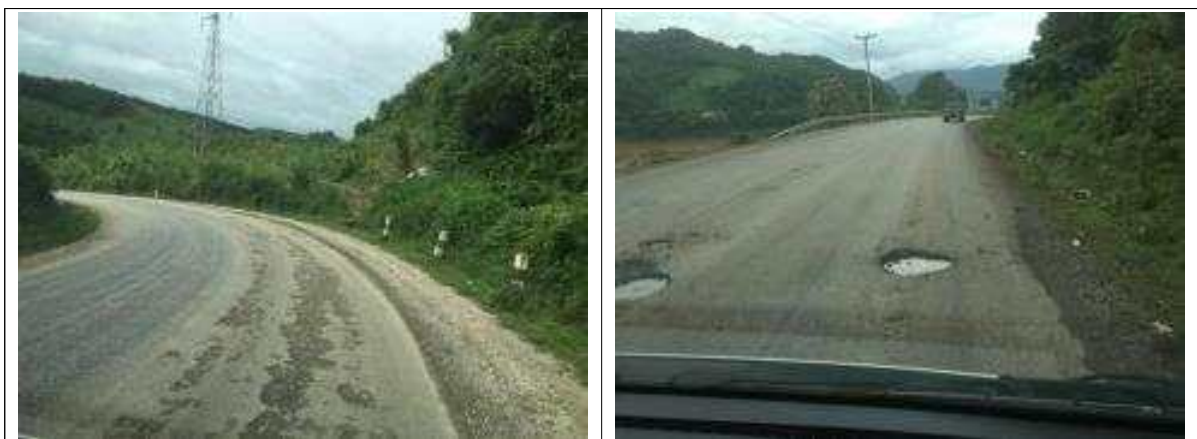
<그림 17> 사업구간 노면과 도로상태 및 도로 파손 구간
