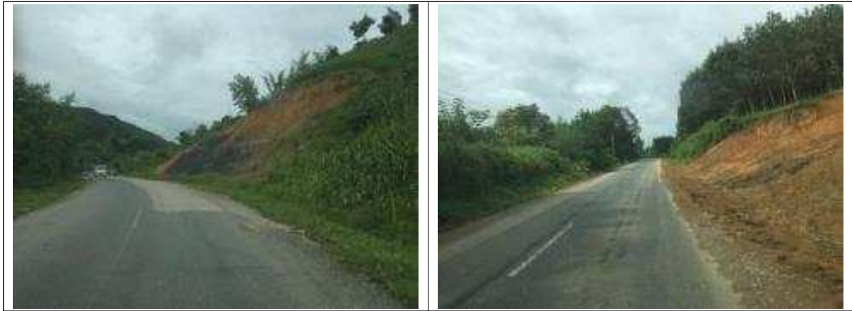
<그림 15> 사면 구강 및 사면 슬라이드 피해 구간
