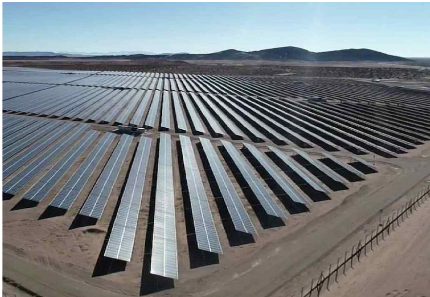
* 동 건 사업 부지 인근에 위치한 우유니 태양광 발전소(2018, 60MW)
