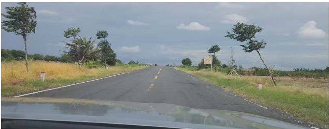
[그림 20] 1. 2차 사업구간 전경 (투바이-켄14호교량 구간)
