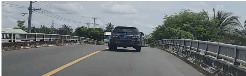
[그림 21] 투바이-나박수로-켄14호 교량 구간 현장조사 장면 ①
