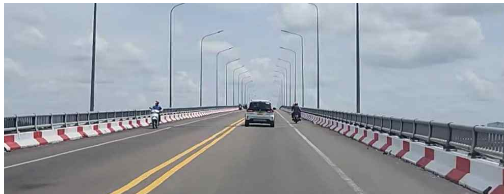
[그림 10] 딱까우 우회도로 현장조사 장면 ①
