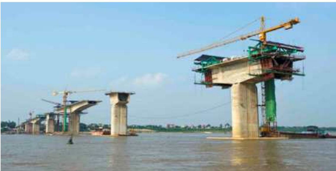
<그림 4> 공사 중인 빈턴교량
