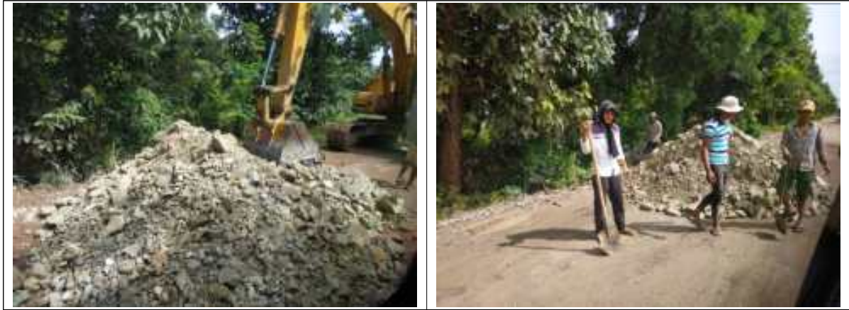
<그림 17> 긴급 보수공사 시행 전경
