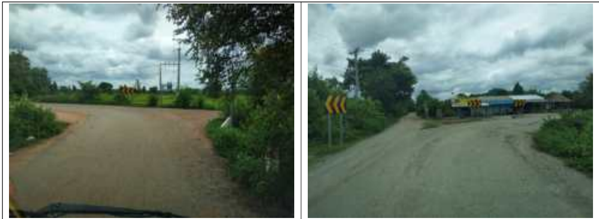
<그림 13> 좌로 굽은 및 우로 굽은 도로 안전시설
