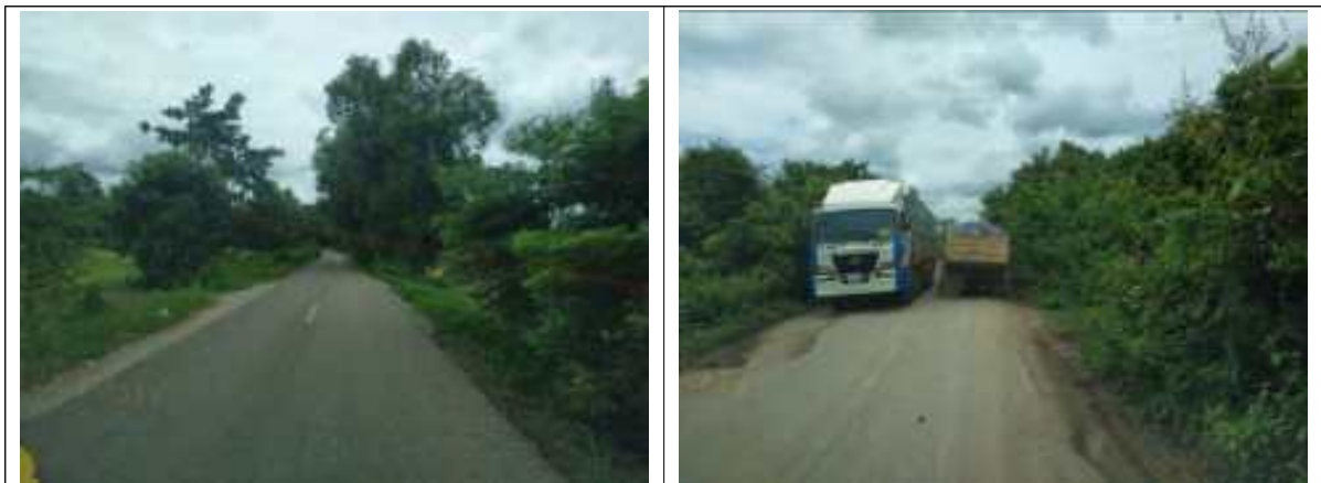
<그림 12> 사업구간 및 도로 파손부 전경
