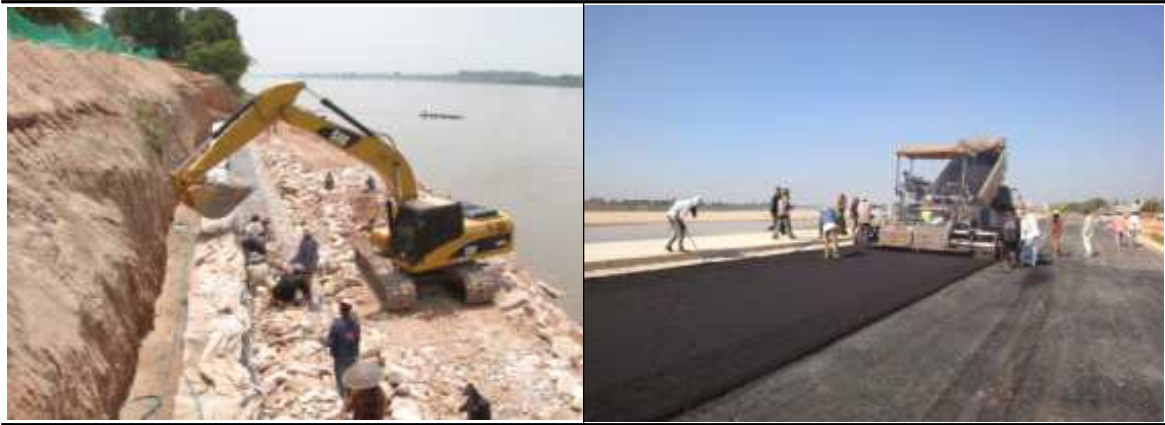
<그림 Ⅲ-27> 작업 중인 한국 건설 중장비 (준공보고서)
