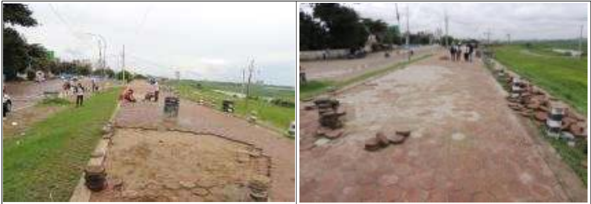
장기위탁기관인 후지와라가 수행하는 제방 상단의 인도포장용 블럭 보수장면
