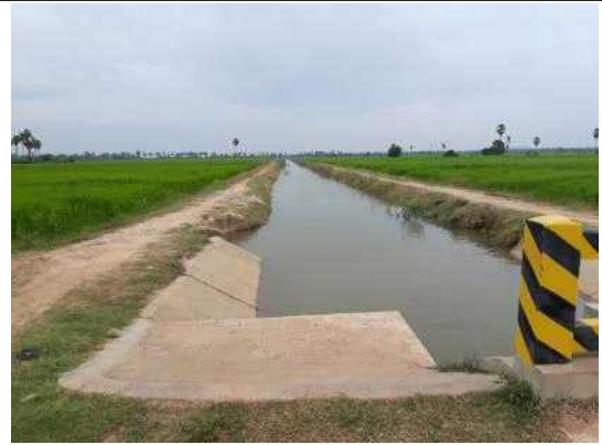
상부 수로 시점부
