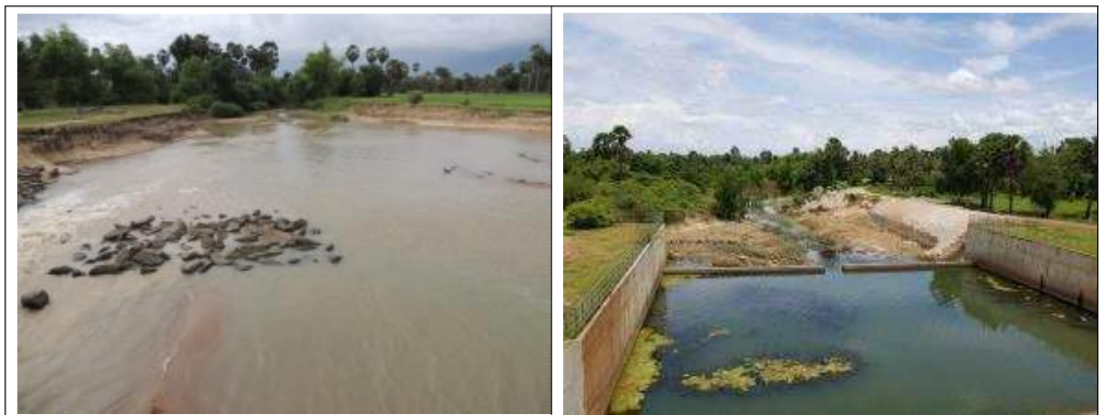
<그림 V-1> 댐 여수로 하류의 제방이 훼손된 모습
