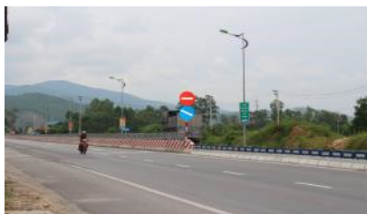
<그림 7> 베트남 정부 예산에 의한 도로 확장 및 보수 구간
