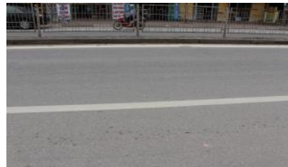
<그림 6> 양호한 도로 상태
